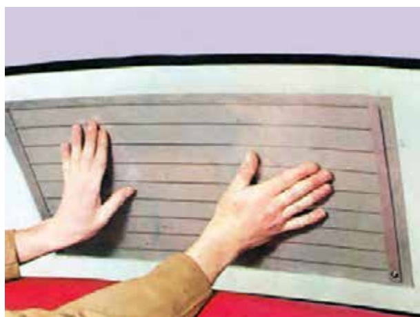
شکل ۹-۳- نحوه چسباندن المنت حرارتی
